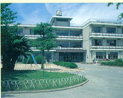
鉄筋旧校舎(昭和39年～)
