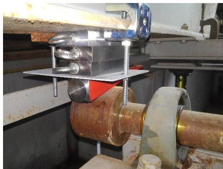
図 7 既設ジャッキ作動部へのスペーサ設置
