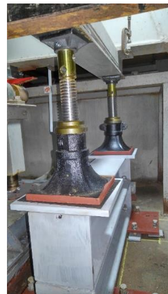
図 6 増設ジャッキの作動状況
