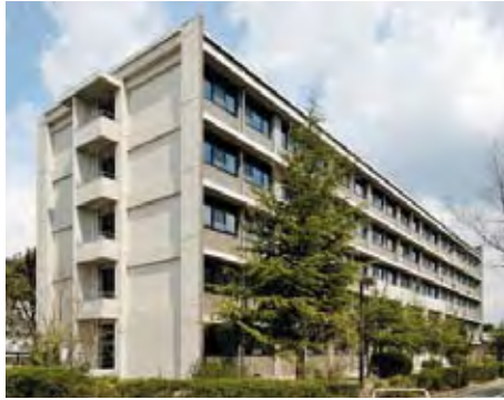
改修後の総合研究棟(文法経系)
