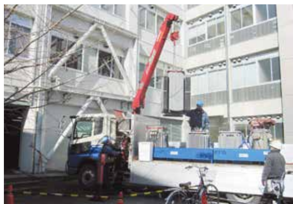
搬出作業の様子
