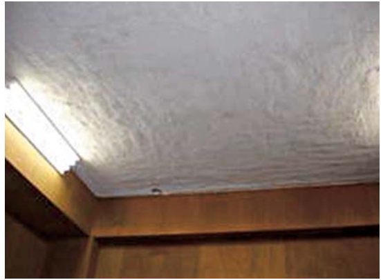
天井部が岩綿であるとされた室
