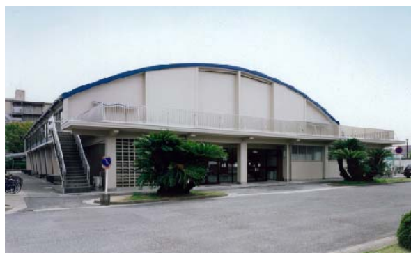
改修後の清水記念体育館
