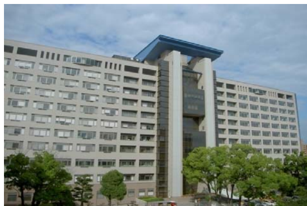
完成した入院棟（一期：写真左側、二期：写真右側） （総工費 一期：89億9,500万円 二期：68億3,100万円）
