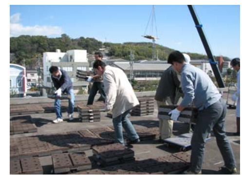
管理棟屋上緑化資材設置作業
