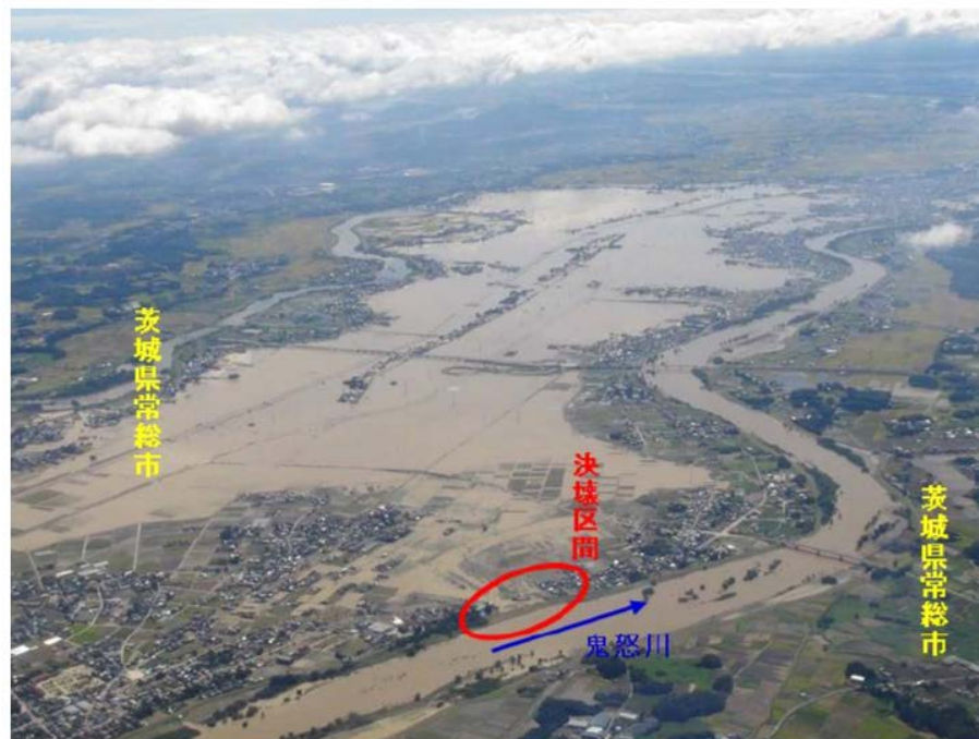
図 2.15 決壊区間航空写真 (平成 27 年 9 月 11 日撮影) (決壊区間の上流側から下流側を撮影)
