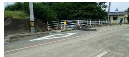
陸閘の存在を確認
