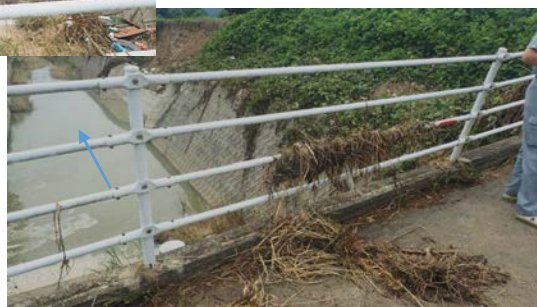
橋梁部の溢水の確認, ガードパイプが上流側へ傾斜
