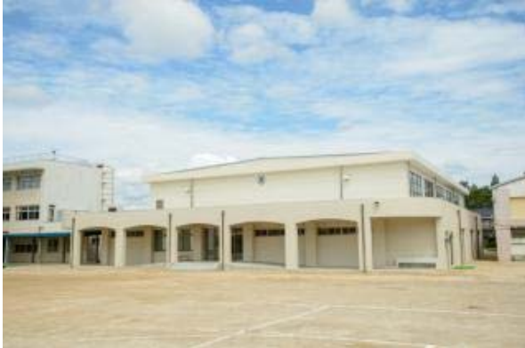
完成した体育館
